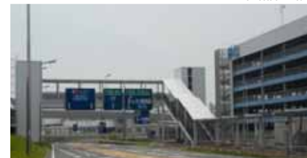
P 4 簡易立体駐車場と連絡歩道橋
