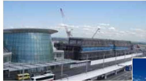
第2旅客ターミナル本館増築工事
